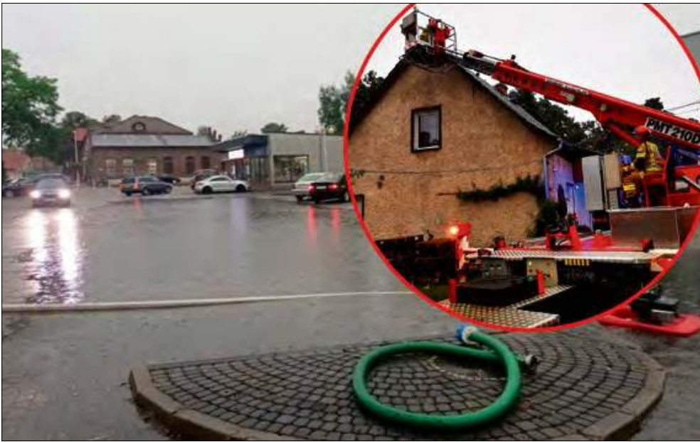
W Choruli doszło do uszkodzenia dachówki, a w Gogolinie zalało parking przed sklepem.
