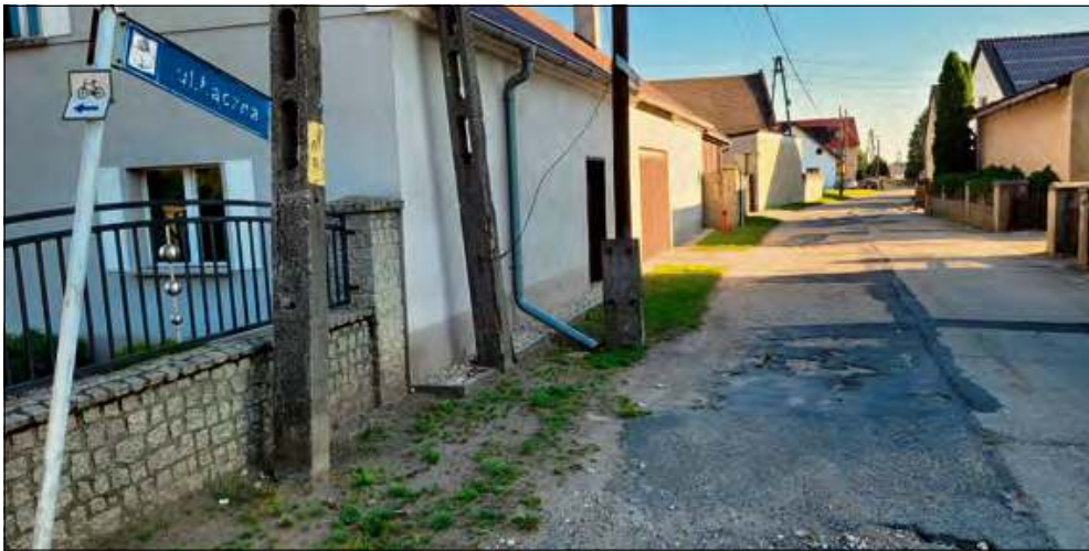
Ulica Łączna potrzebowała już remontu.
