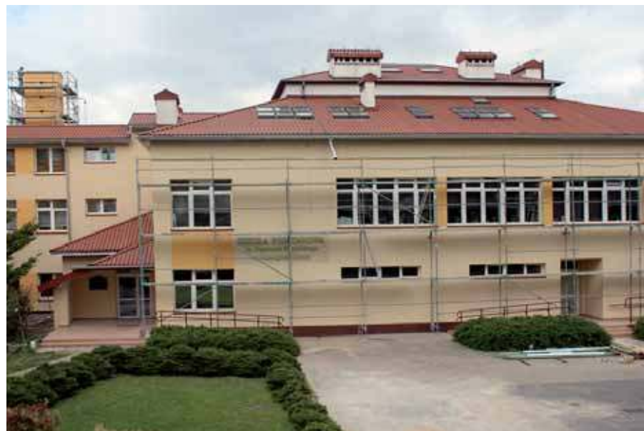
Prace przy termomodernizacji gmachu Szkoły Podstawowej w Opinogórze jeszcze trwają
