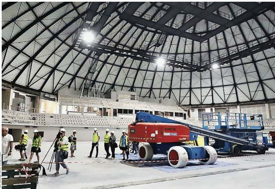
Obecnie w Uranii trwają intensywne prace wykończeniowe
