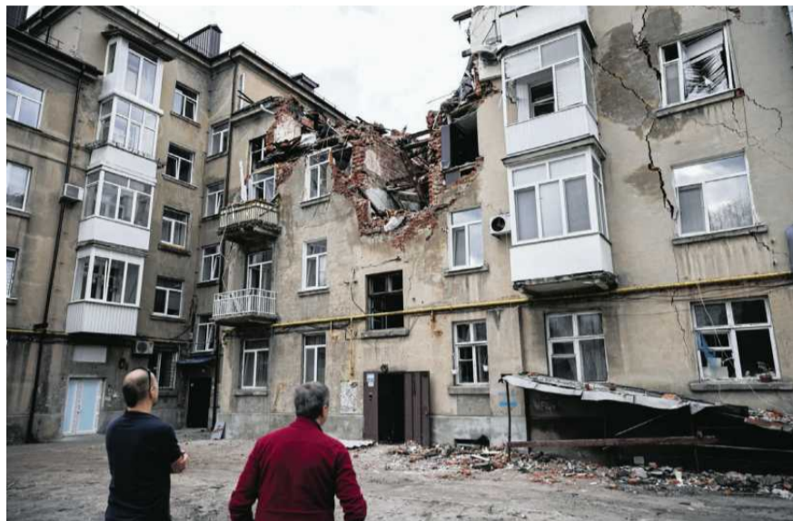
• Zniszczone dronami budynki mieszkalne w Sumach, 7 kwietnia 2024 r.
