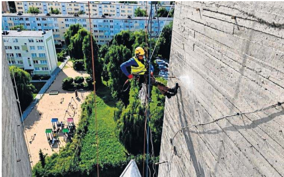
Inwestycja obejmuje naprawę i reprofilację elementów powłoki żelbetonowej.
