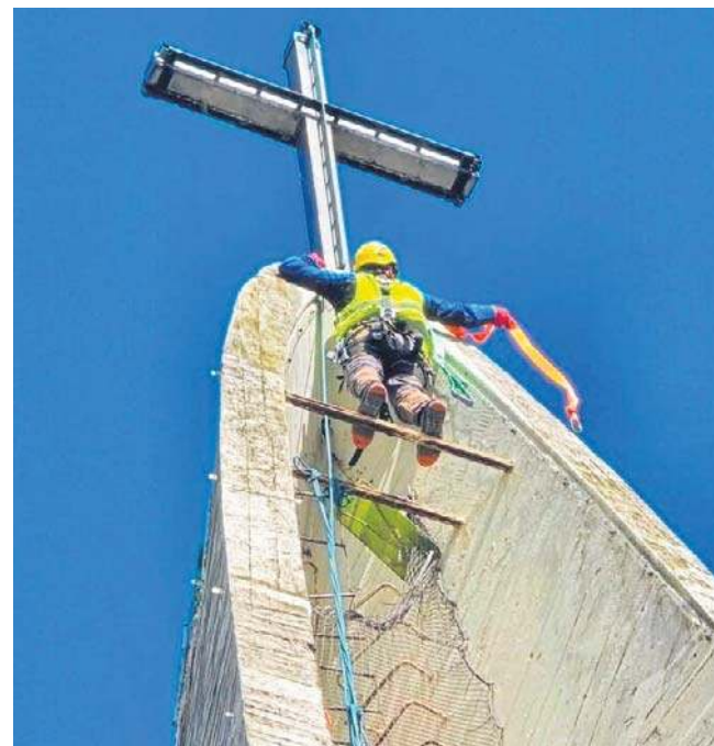
Obiekt remontują... alpiniści.
