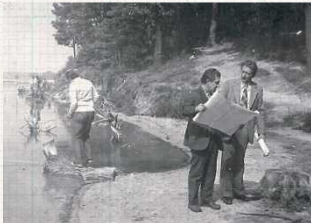
Wyznaczanie terenów pod budowę Zalewu Zemborzyckiego, lata 70. XX wieku
