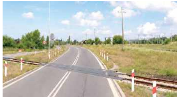
Po blisko dwóch latach starań zmieniono organizację ruchu na przejeździe kolejowo-drogowym. Zniknął znak B-20 „STOP”, który przez długi czas był powodem uwag i interwencji kierowców
