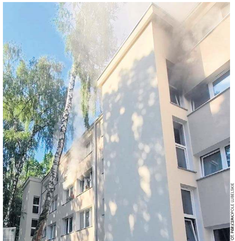
Widać jeszcze dym wydobywający się z okna. Trwa ustalanie przyczyn pożaru
