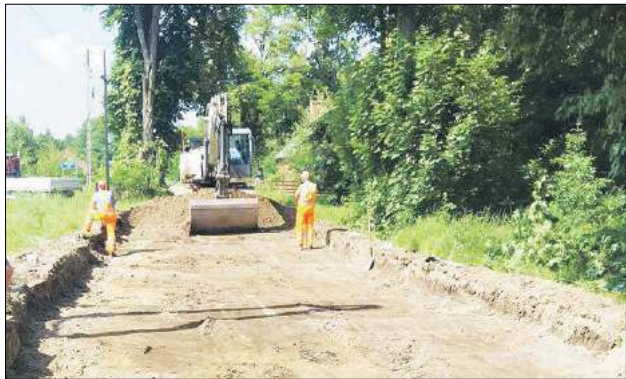
Jeszcze w tym roku powstanie droga przez Wolę Dubowską. Niedawno ruszyły prace
