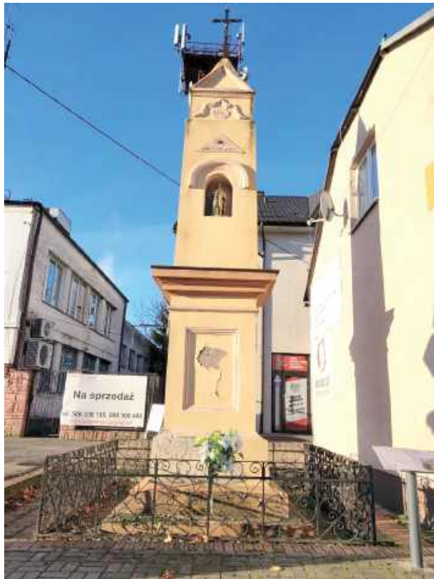
Kapliczka przed remontem
