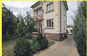
Piętrowy dom w Białej Podlaskiej, z użytkowym poddaszem na działce o powierzchni 929 m 2 , 885 851 172
