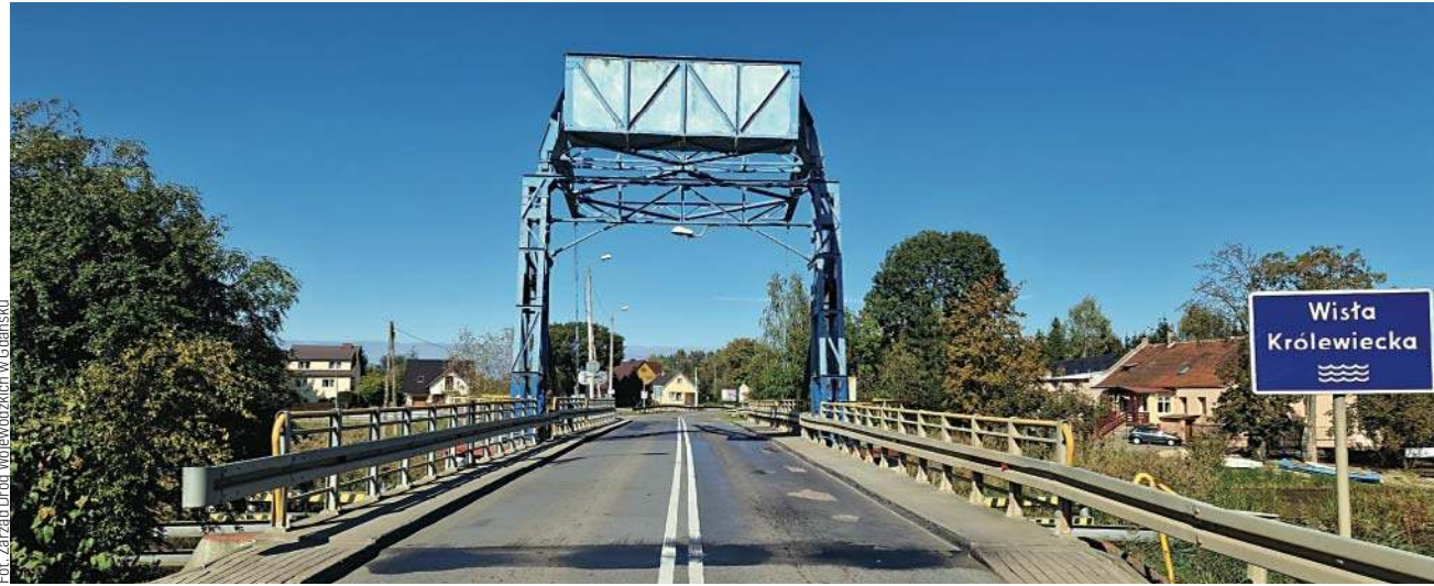
Po zakończeniu inwestycji most w Rybinie dzięki modernizacji mechanizmu podnoszenia oraz wzmocnieniu konstrukcji i nasypów odzyska pełną funkcjonalność
