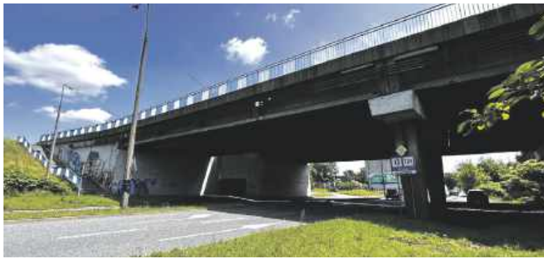
Wiadukt nad Siemianowicką ma kilkadziesiąt lat
