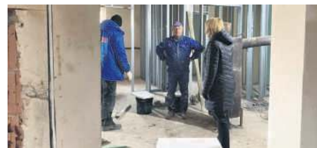
W budynku, w którym ma się mieścić m.in. wypożyczalnia sprzętu narciarskiego, budowlancy zaczynają montować sufit.
