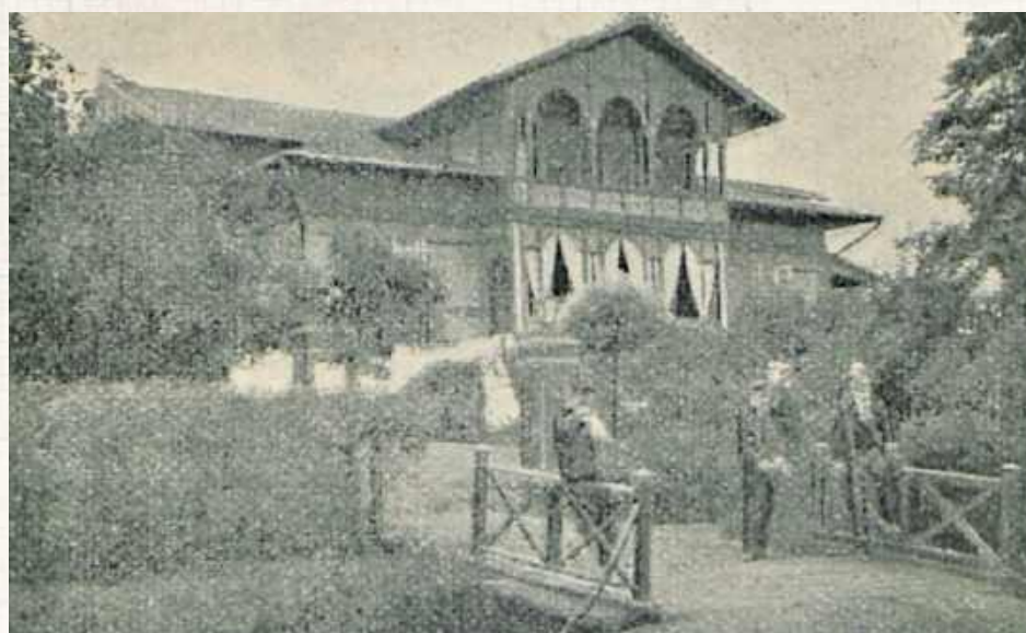
Nałęczowską bazą Benniego była, należąca do jego żony, willa Podgórze. To tu mieszkał, prowadził gabinet oraz przyjmował gości. Zdjęcie z 1907 roku
