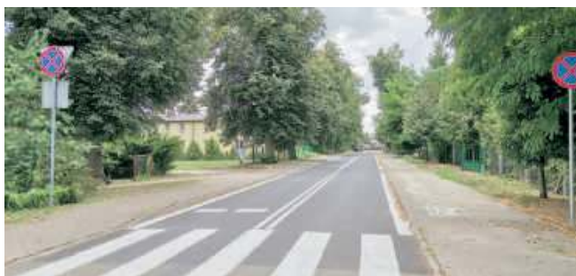
Tak wygląda ul. Lipowa po zakończeniu prac
