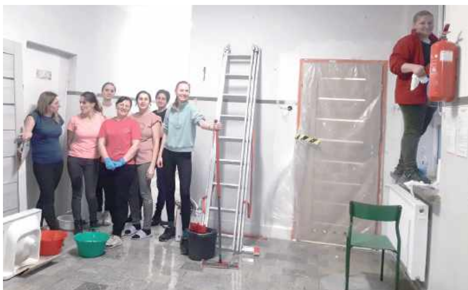
W trakcie ferii zimowych chętni do działania rodzice oraz pracownicy niepedagogiczni zjednoczyli siły, aby wspólnie przeprowadzić remont (fot. SP Siedliska)
