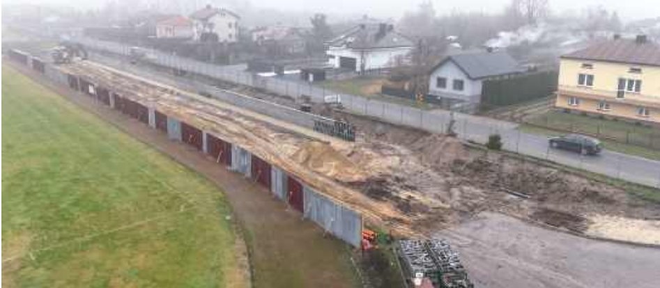
Jedną z trwających inwestycji, która zostanie zakończona w 2025 roku, jest budowa trybun na stadionie miejskim
