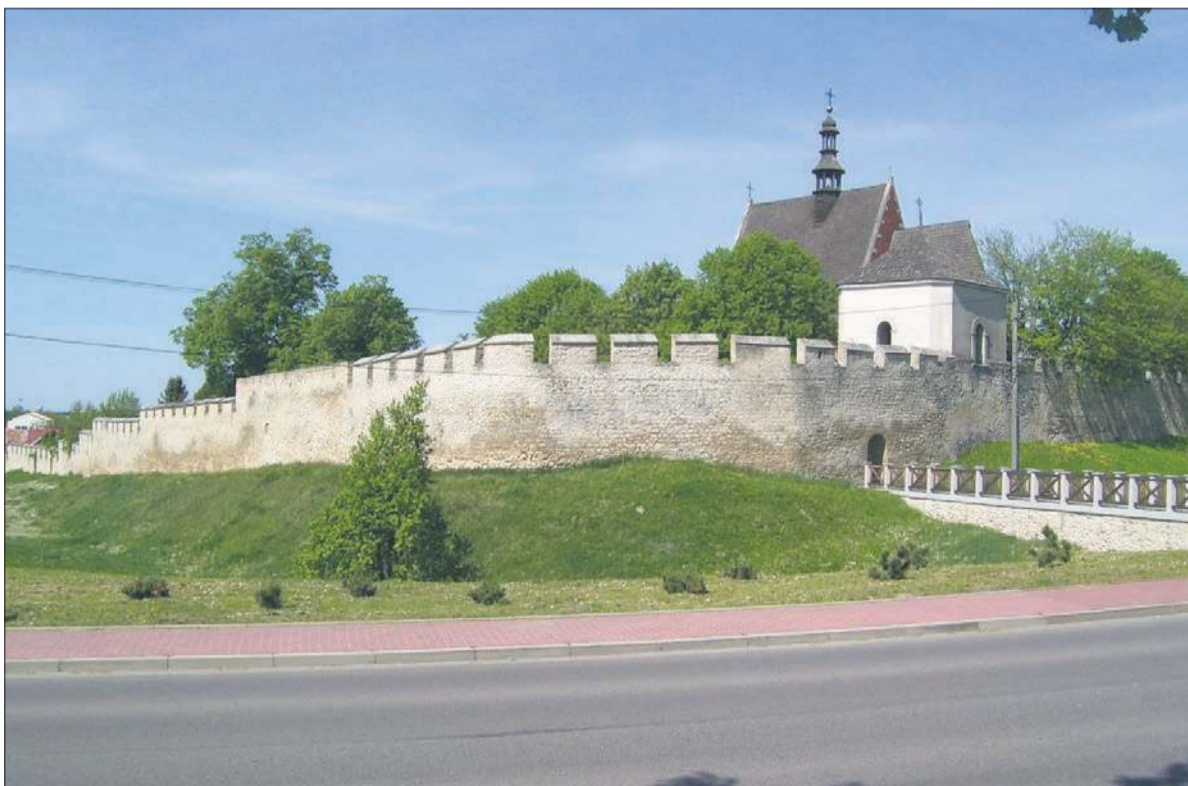
Południowo-wschodni fragment murów miejskich z dzwonnica. W tle dach kościoła pw. św. Władysława
