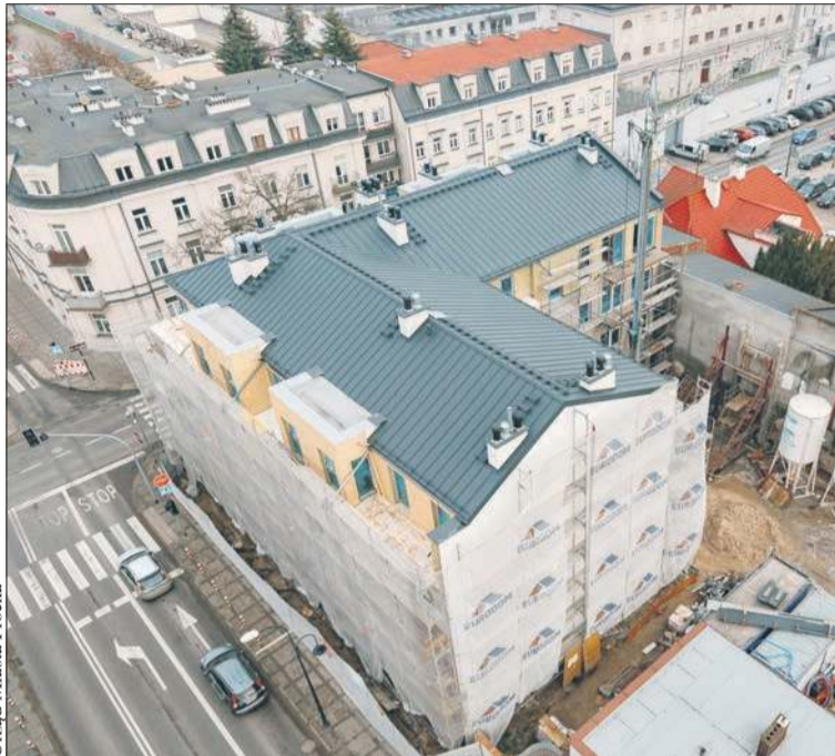
Przy ul. 1 Maja 2 powstaje nowa kamienica z 35 mieszkaniami
