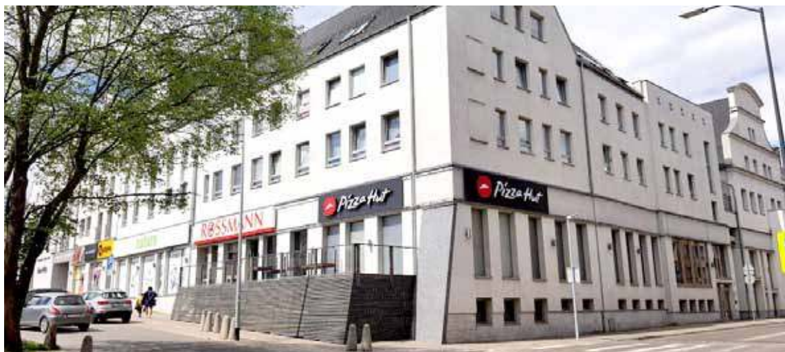
Na ścianie lokalu Pizza Hut w Galerii Starówka zamontowano już charakterystyczne szyldy tej znanej sieci
