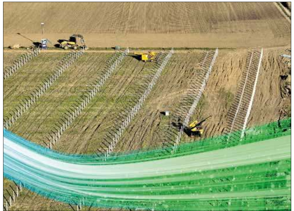
Budowa farmy fotowoltaicznej Dygowo I
