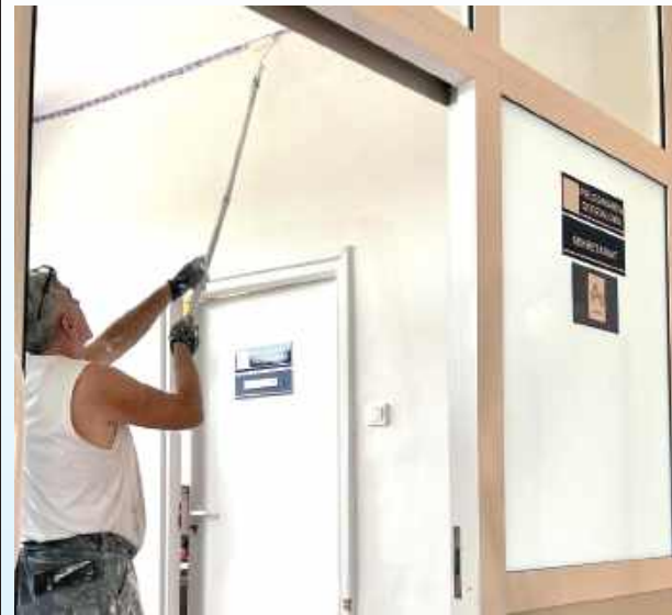
W Zamojskim Szpitalu Niepublicznym cały czas trwa remont. Wkrótce ma przyjechać nowy sprzęt
