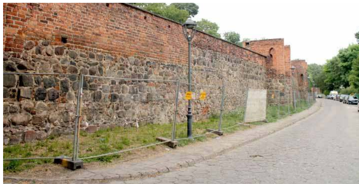
Ponad 1 000 000 zł dofinansowania wydane jest na renowację murów obronnych wzdłuż ul. Klasztornej
