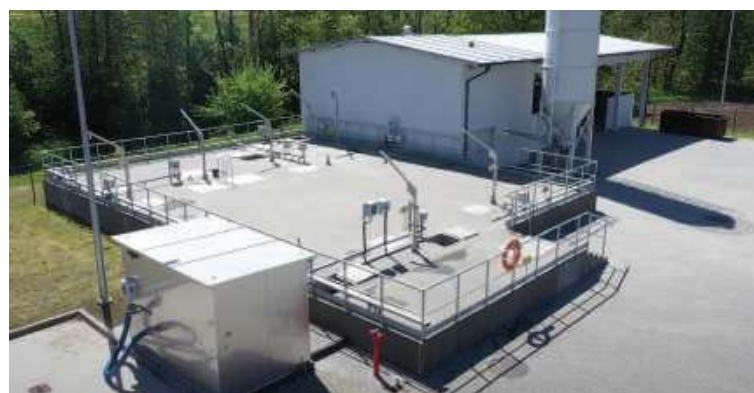
▲ Widok z drona - oczyszczalnia w Księżpolu
