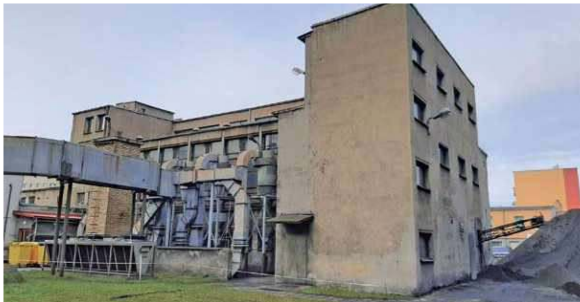
Nowa kotłownia to jedna z kluczowych inwestycji w szpitalu (fot. archiwum nowosolskiego szpitala)
