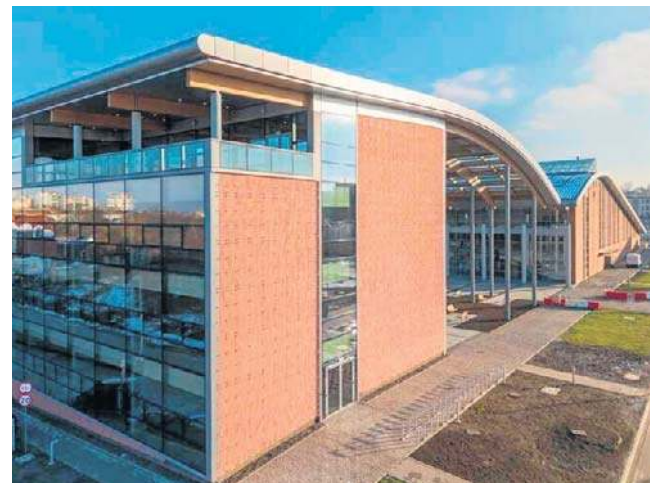
Nowy budynek dydaktyczny UPJPII połączony z biblioteką
