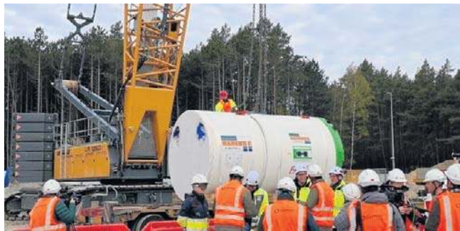
Basia trafi do komory startowej mikrotunelu
