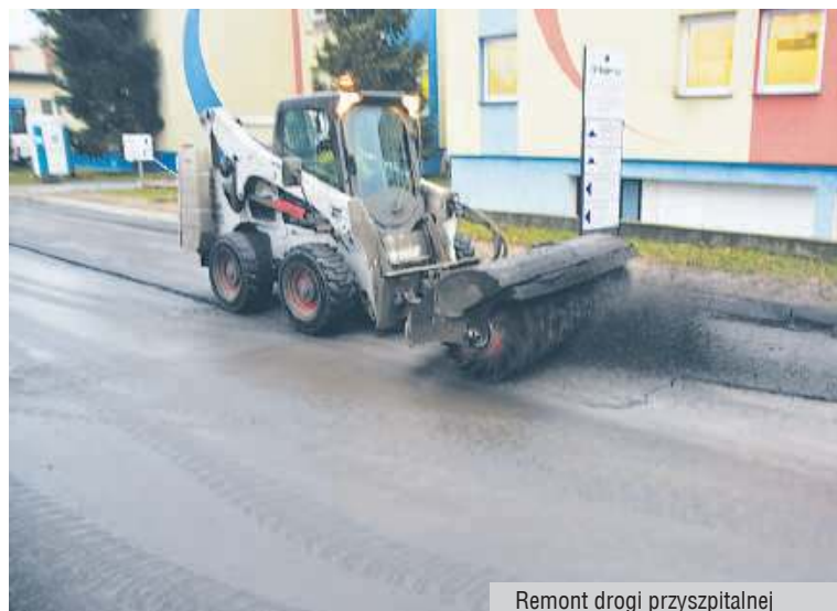
Remont drogi przyszpitalnej
