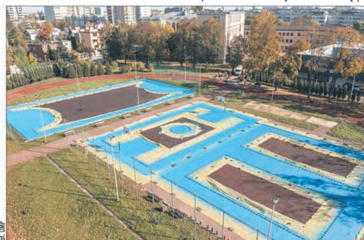
Na kompleksie sportowym przy Jagiellonce trwa renowacja poliuretanowej nawierzchni
