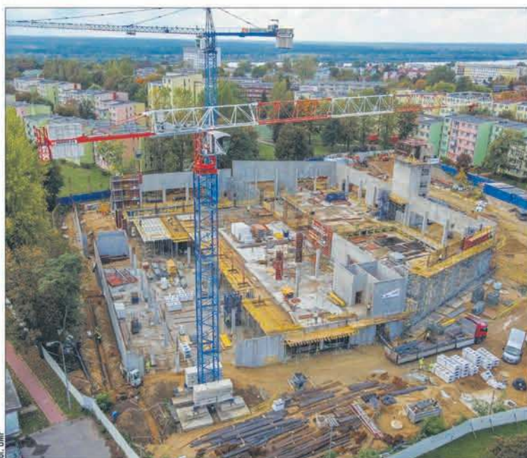
Budowa jest na tyle zaawansowana, że widać zarys przyszłej pływalni
