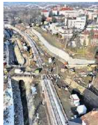
Prace w rejonie przejazdu kolejowo-drogowego
