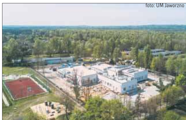
Koniec prac przewidziano na lipiec
