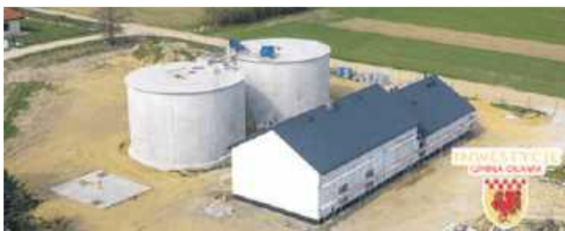
Stacja Uzdatniania Wody w Siedlcach
