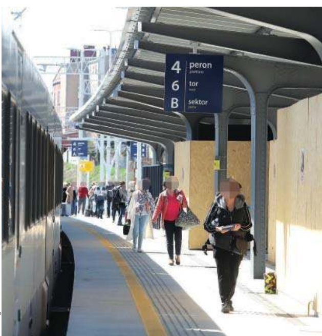
Po peronie 4. wyremontowane zostaną pozostałe trzy perony
