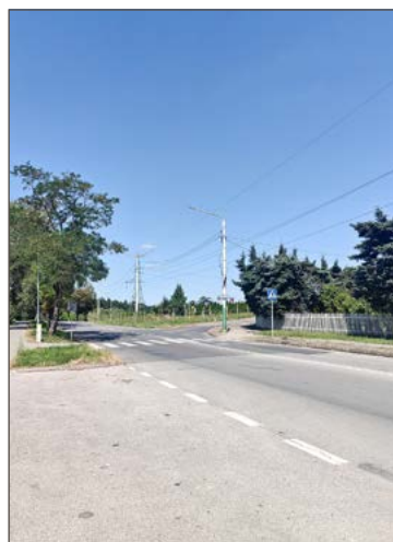
Ta ulica nie jest bezpieczna, stąd plan jej modernizacji.
