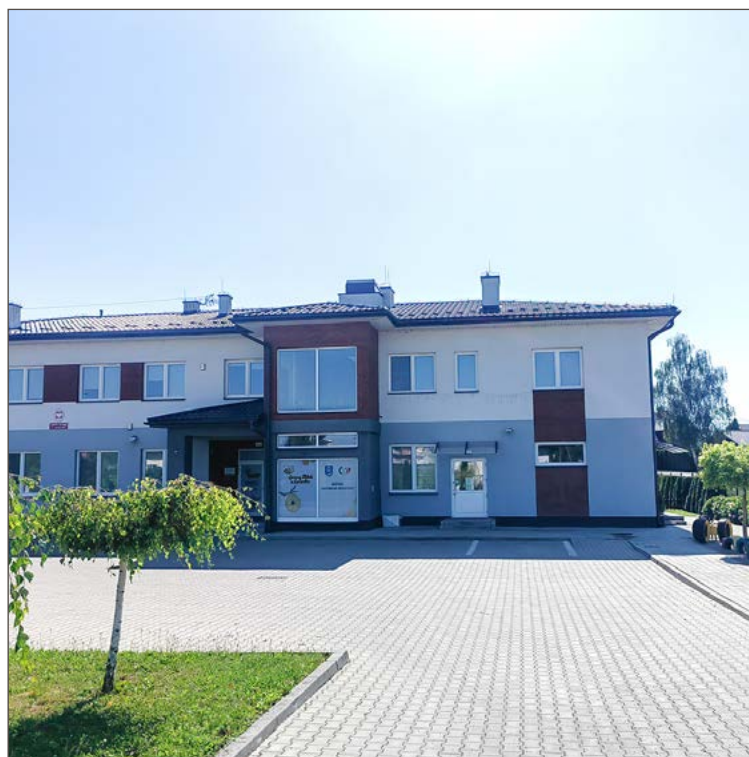
Wybory nowego sołtysa odbędą się w budynku wielofunkcyjnym.
