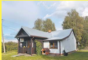
Dom z pompą ciepła i fotowoltaiką – Janów Podlaski, 885 851 172
