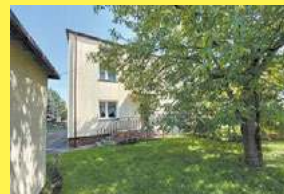
Dom położony w Białej Podlaskiej, blisko ulicy Podleskiej, powierzchnia działki 822 m 2 , powierzchnia domu 180m 2 , na działce znajduje się drugi budynek do zamieszkania lub pod działalność gospodarczą, Tel. 885 851 172.
