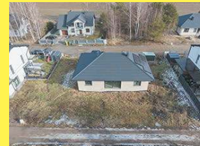
Dom z pompą ciepła i fotowoltaiką - Porosiuki, 604 494 489
