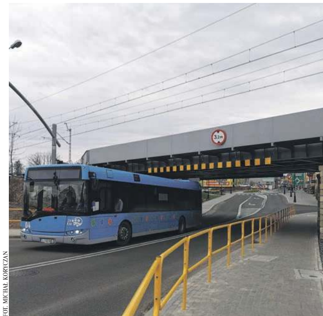
Wiadukt na Krakowskiej w Chrzanowie
