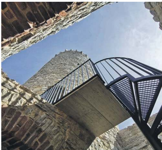
Ścieżka prowadząca na wieżę została odnowiona
