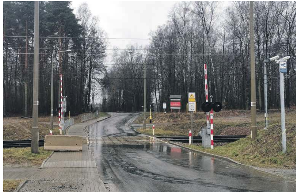
Przejazd kolejowy ul. Tenczyńskiej w Dulowej
