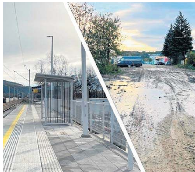
Tak wygląda dojście do przystanku na Gorzkowie - po deszczu tonie w błocie
