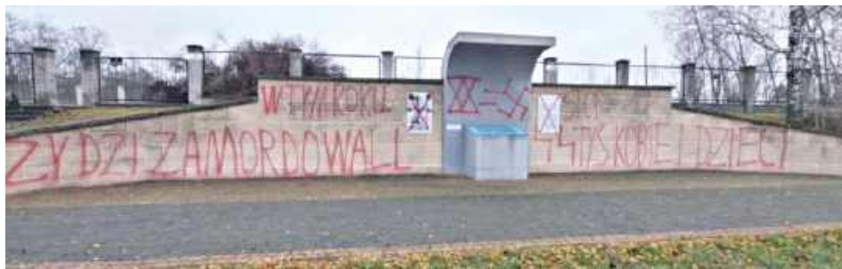
W nocy z 26 na 27 listopada 2024 dokonano aktu wandalizmu. Zniszczona została ściana pamięci na cmentarzu przy ul. Konopnickiej w Biłgoraju
