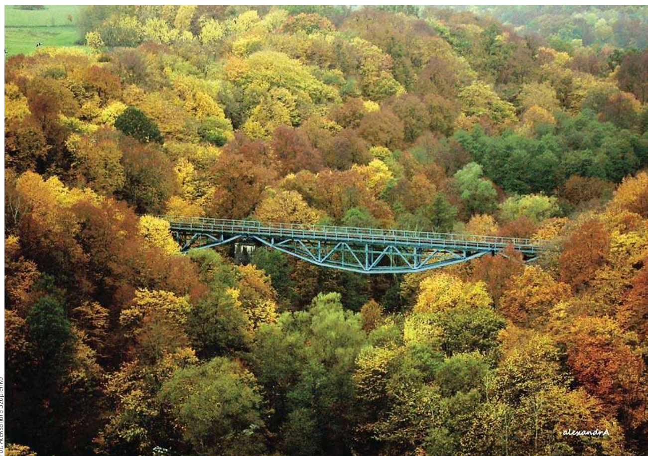
Most kolejowy w Dolinie rzeki Wąszy ma 28 metrów wysokości
