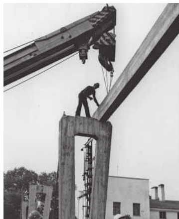
Budowa kładki nad torami
