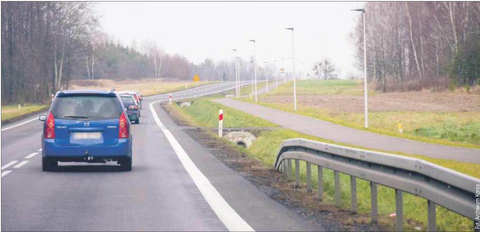
Budowa nowego przebiegu drogi krajowej nr 9 nabiera coraz poważniejszych kształtów.
