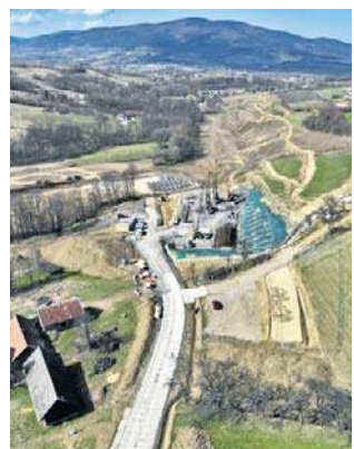
Budowa portalu startowego dla maszyn TBM w Stróży
