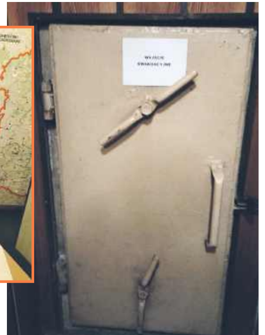
Chełmskie schrony wymagają nie tylko remontów, ale także specjalistycznego wyposażenia m.in.: szczelnych drzwi i filtrów powietrza.
