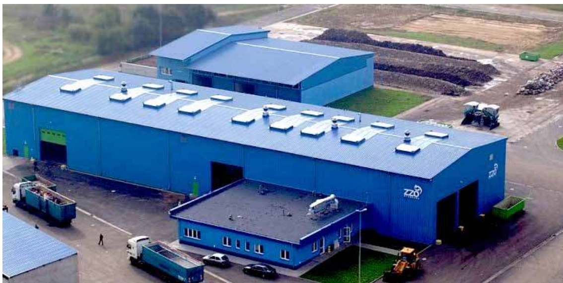
Około 16 tysięcy ton odpadów w skali roku odbieranych jest z terenu Stargardu o wysokiej energetyczności. Około 30% z tych odpadów trafi z ZZO do Szczecina.
