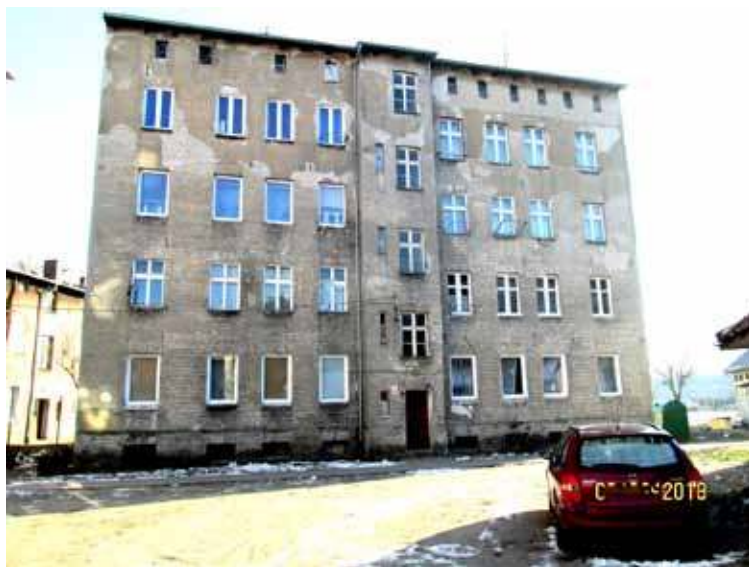
W kamienicy przy ulicy Bogusława IV wymienione zostaną piece gazowe, wykonane zostanie ocieplenie ścian oraz wymieniona elewacja budynku
