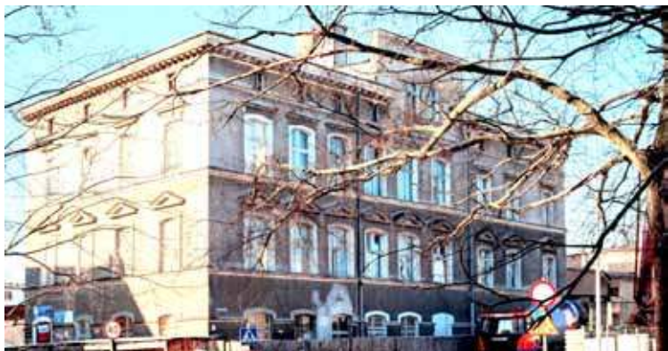
Rozpoczęły się prace renowacyjne budynku, w którym ma powstać Stargardzkie Centrum Nauki
