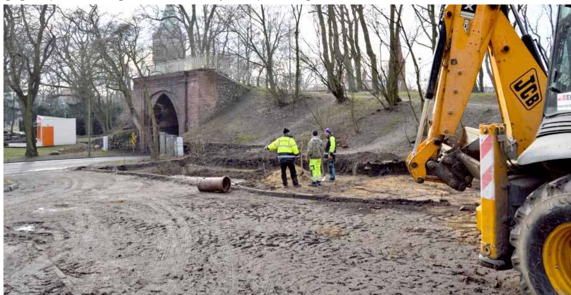
Ruszyły prace budowlane, w wyniku których powstanie 15 miejsc postojowych za kościołem św. Jana
