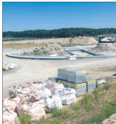
Tak wygląda budowa ekspresówki pod Komarowem-Osadą.
