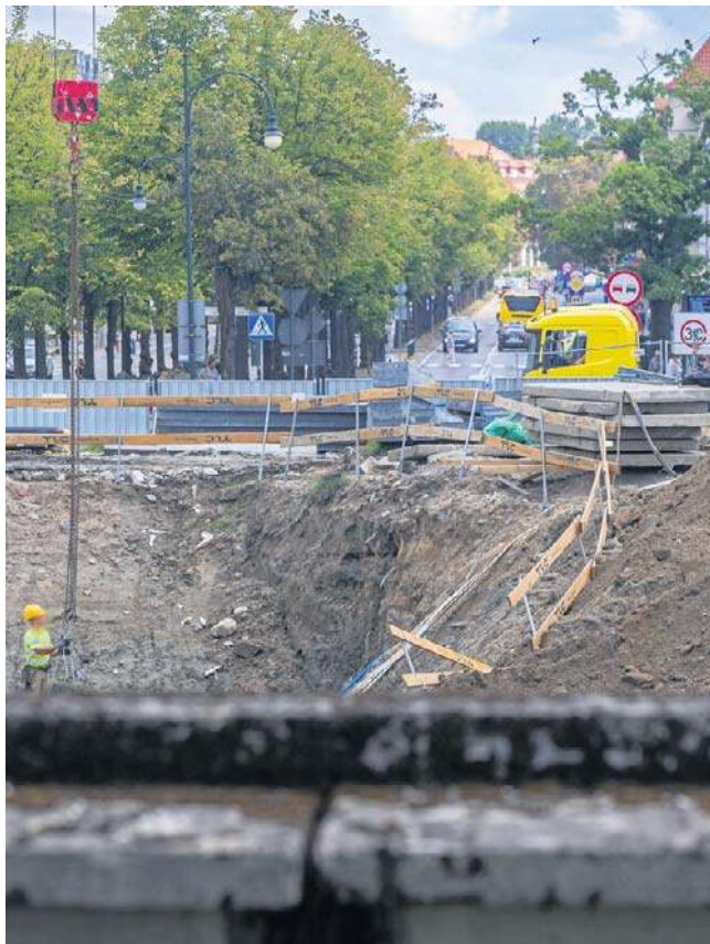
Trwa budowa nowego dworca kolejowego w Słupsku
