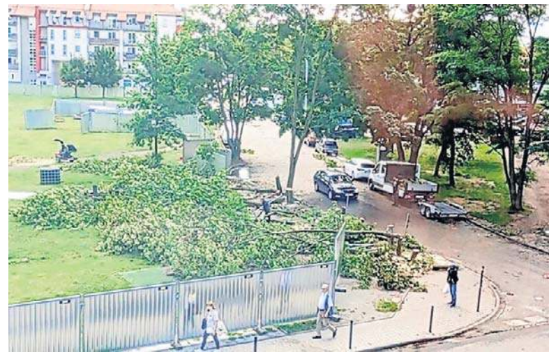
Wycinka drzew na Brochowie pod budowę nowego TBS
