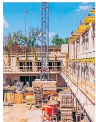
Budowa osiedla na Dołach jest mocno zaawansowana
