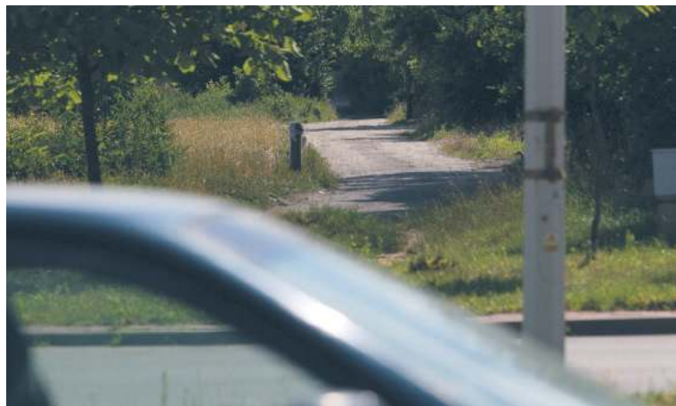
Budowa Al. NSZZ „Solidarność”, wyceniona na ok. 16,4 mln zł, na rządowe dofinansowanie z Funduszu Dróg Samorządowych musi jeszcze poczekać
