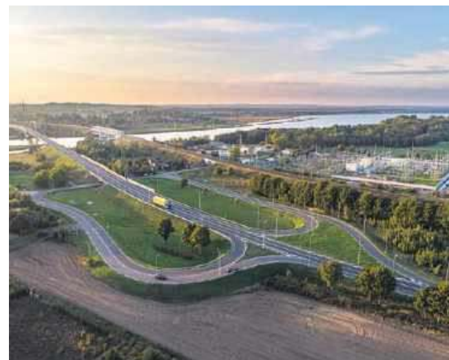
Rozbudowana stacja elektroenergetyczna Reclaw.
