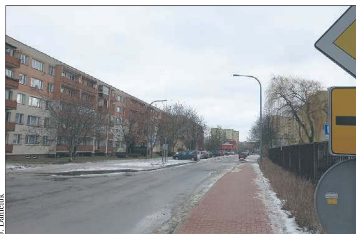
Przebudowa fragmentu ulicy Lasockiego zakończy się wiosną, po ułożeniu ostatnich warstw asfaltu
